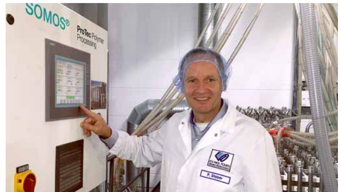
Peter Stober, Technischer Geschäftsführer bei EK-Pack, kann am Display überprüfen, ob die Verbindungen zwischen Schlauch und Leitung richtig angekuppelt wurden.
